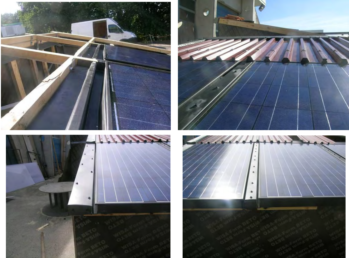
Figure 4 : Position des fixations des pareclozes
